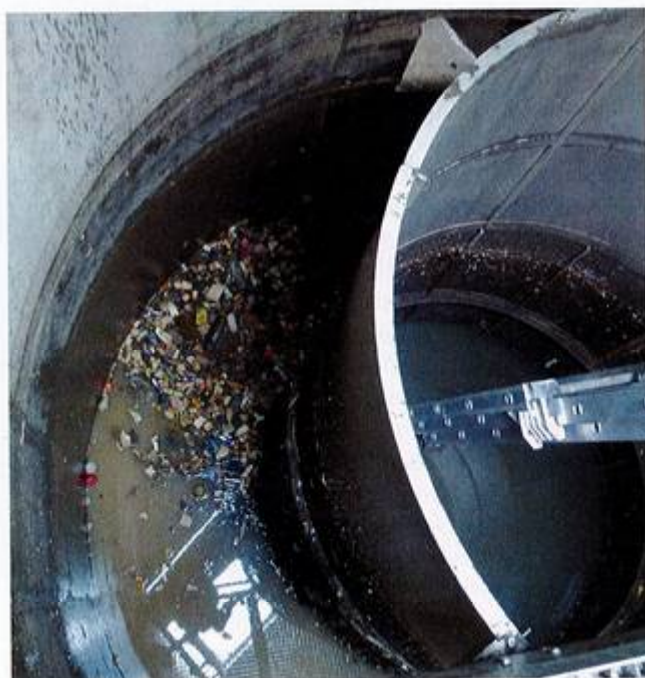
Le séparateur hydrodynamique est adapté au traitement de flux de pollution très hétérogènes.
