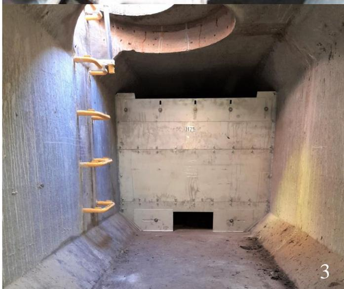
Photos 1 et 2 : Hydrostyx installés dans un collecteur unitaire afin d'optimiser le transfert des effluents vers la station d'épuration.
