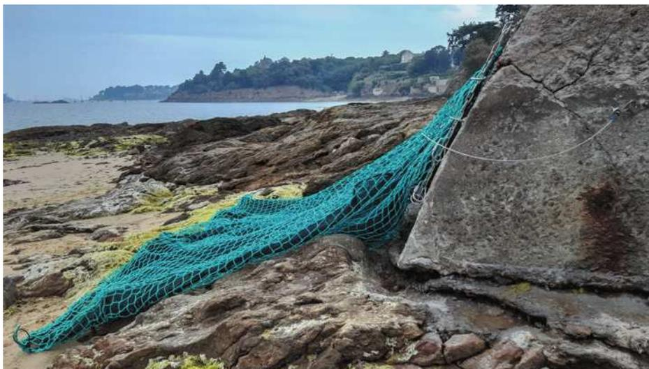
*L'Hydrofilet est un dispositif de dégrillage par filet filtrant. Sa mise en œuvre est conseillée lorsque des macrodéchets se répandent dans le milieu naturel ou obstruent les réseaux.*
