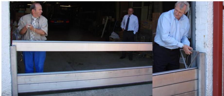
Mais le temps de mise en œuvre d'un tel dispositif est long et sa fiabilité laisse à désirer. Il faut donc envisager, lors des études de projets, des mesures de protections comportant des batardeaux mobiles permettant des temps de réactions plus rapides.
