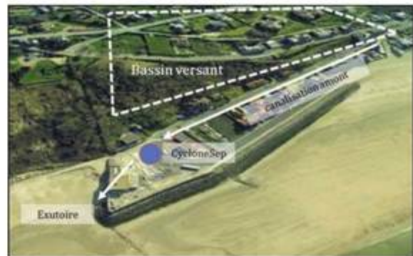
Figure 2. Configuration de l'installation du CycloneSep à Trouville/Mer
