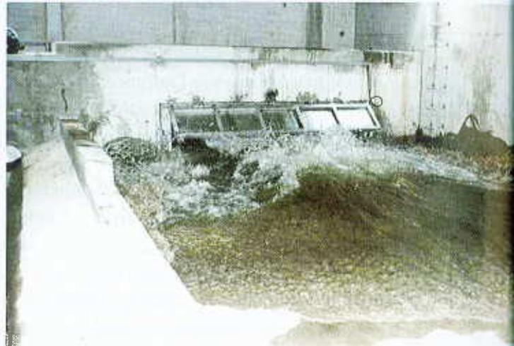
Après la vidange du bassin, un rinçage systématique du radier est effectué avec une temporisation entre chaque ouverture de clapet.
