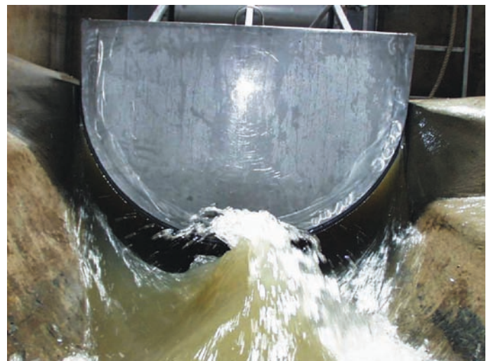
Flot de chasse libéré par un dispositif Hydroguard®
