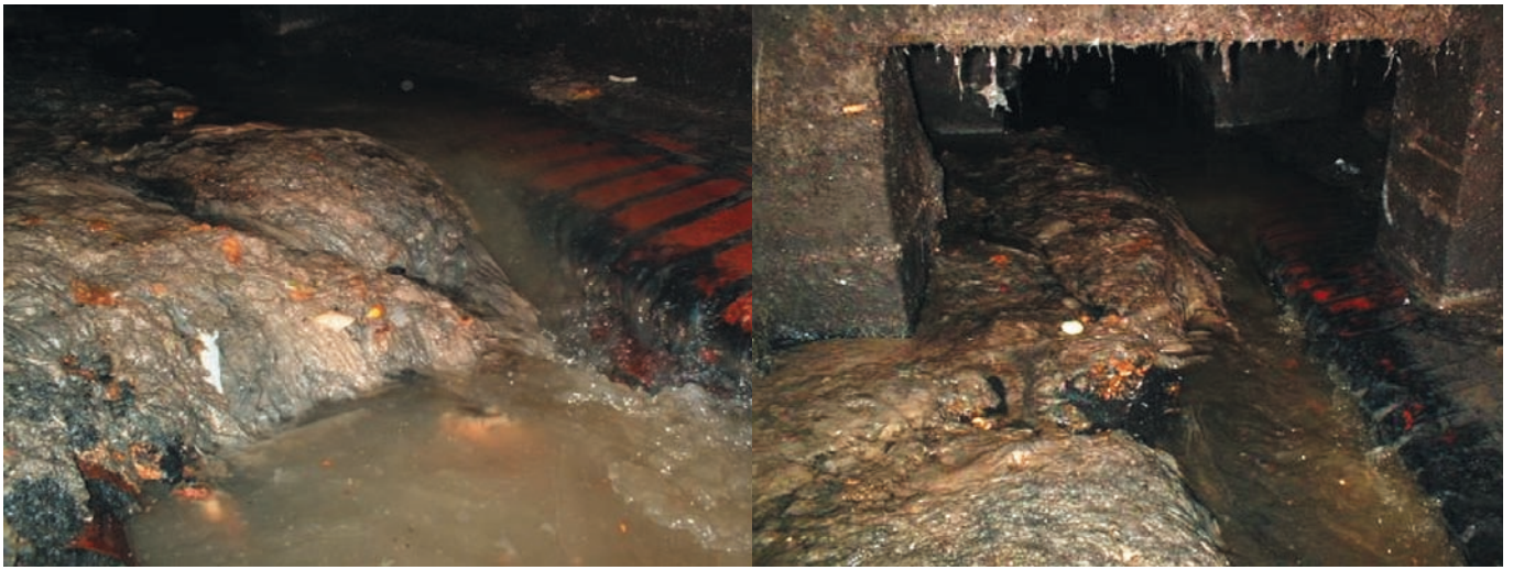
Conduites obstruées par des dépôts.
